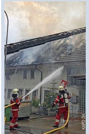
Im Dachstock brannte es.
